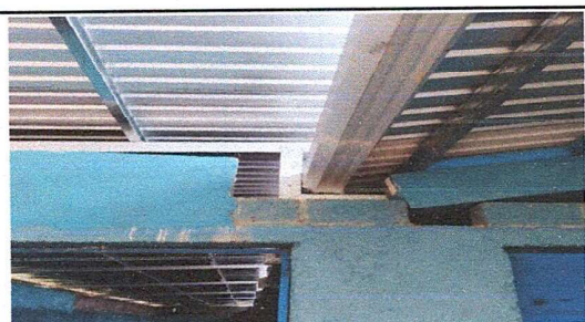
Foto 5: Se instaló de estructura de laminas y laminas troqueladas.
