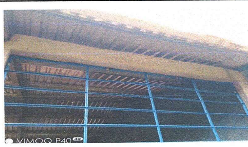
Foto 4: Se cambiaron vidrios y marco de vidrios de ventanas
