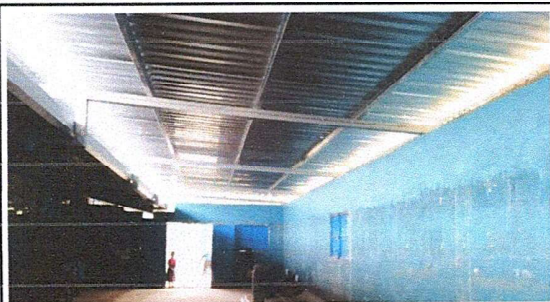
Foto 1: Se cambió estructura de techo y techo del salon. Se cambió estructura de madera a costanera y laminas estructurales
