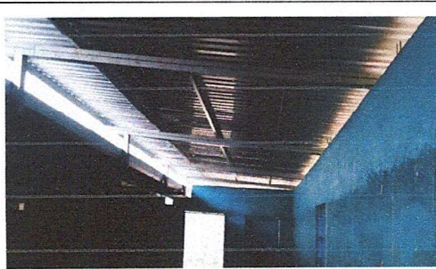
Foto 2: Se subió altura de la pared para que haya ventilacion.
